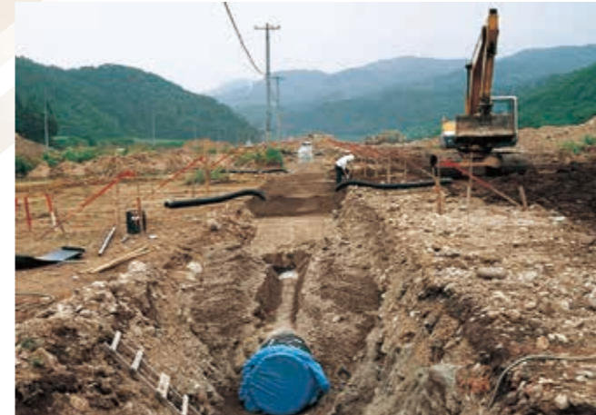
圃場整備小排水路管路化工事
