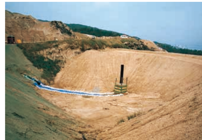
土地造成堅形集排水管工事
