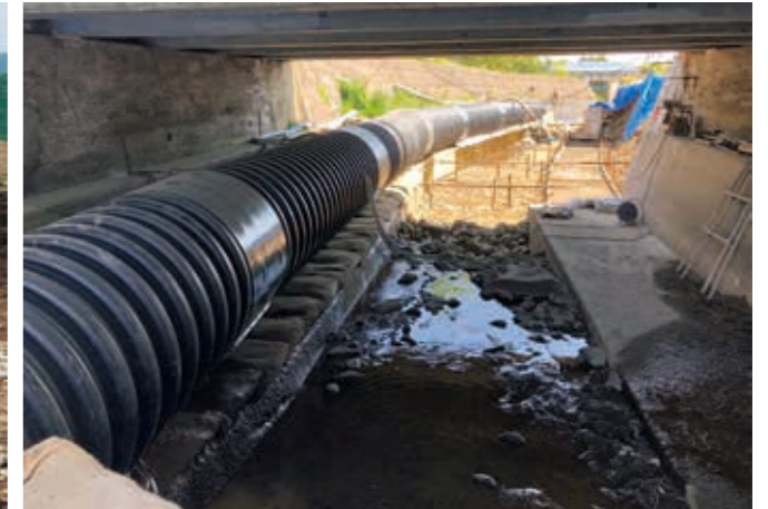
河川改修排水工事
