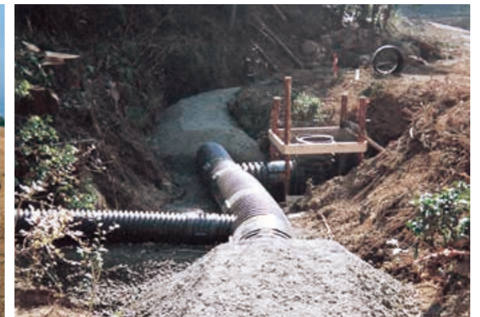
土捨場防災暗渠工事
