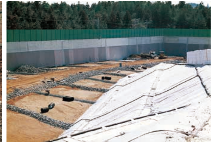
一般廃棄物処理場浸出集排水・ガス抜き管工事
