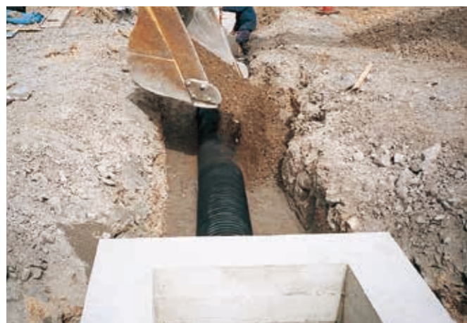
NEXCO用排水管工事
