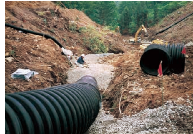
土地造成防災暗渠排水工事
