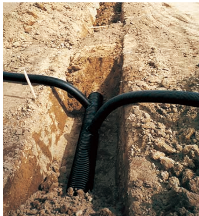
小排水路の管路化事業 排水枝管接続
